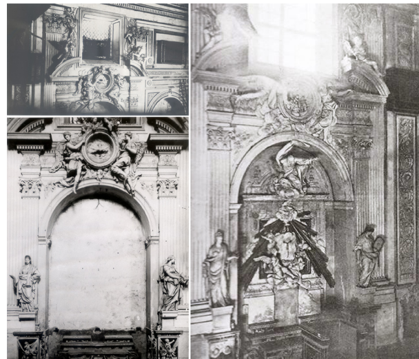
Fig. 2. Foto dell'interno della chiesa scattate nel 1890, poco prima della demolizione.
