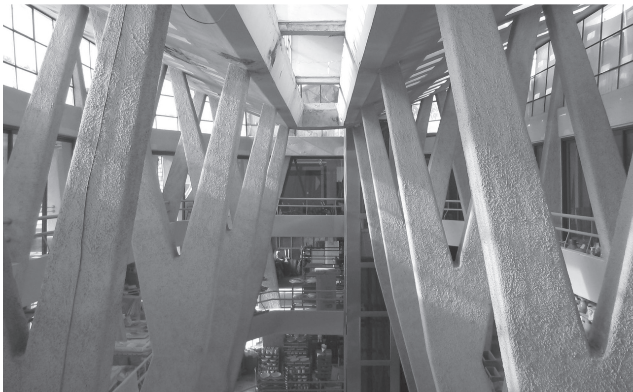
Fig. 6. Dettaglio dei pilastri interni della fabbrica.
