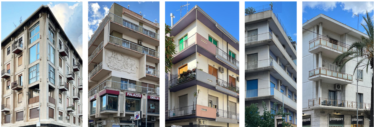
Fig. 8. Soluzioni d'angolo di alcuni isolati localizzati nel centro urbano (foto dell'autrice).
