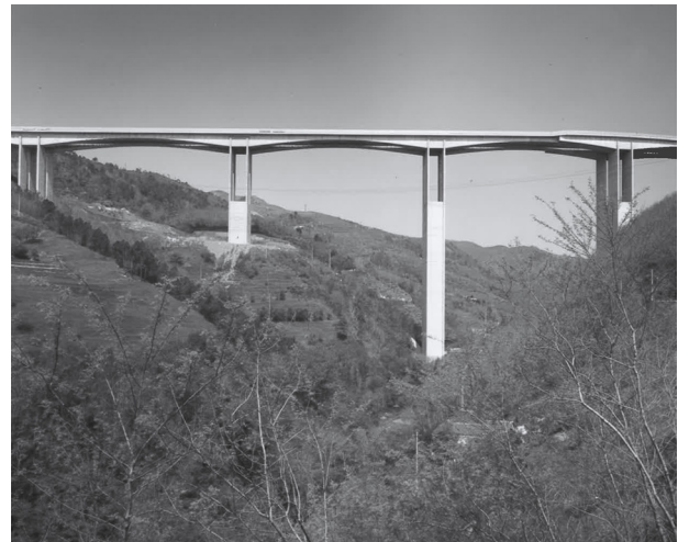
Fig. 11. Viadotto Gorsexio a Voltri per l'autostrada Voltri-Alessandria (Archivio Storico Cooperativa Muratori & Cementisti C.M.C., Ravenna).
