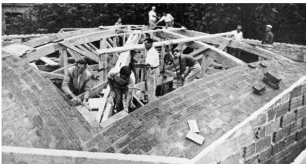
Fig. 1. Costruzione di volte alla catalana per il Mercado Sagrera a Barcellona [Torroja 1957, p. 280].
