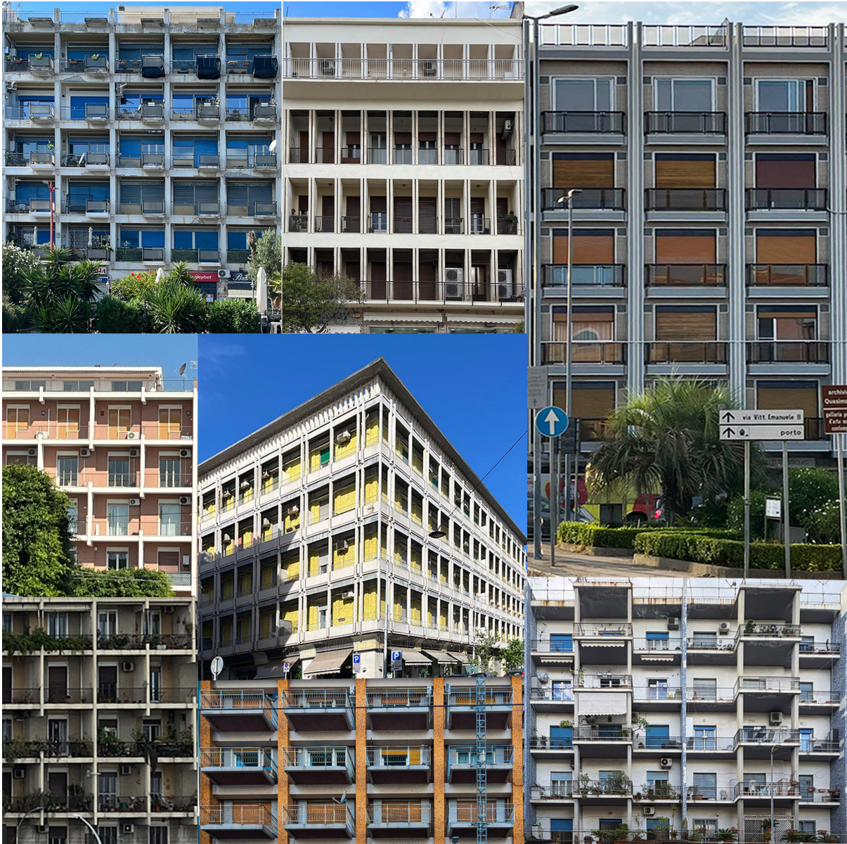
Fig. 7. Edifici con facciata definita da elementi strutturali esterni (foto dell'autrice).
