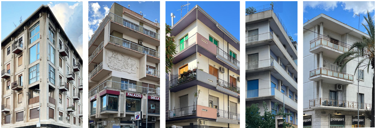
Fig. 8. Soluzioni d'angolo di alcuni isolati localizzati nel centro urbano (foto dell'autrice).
