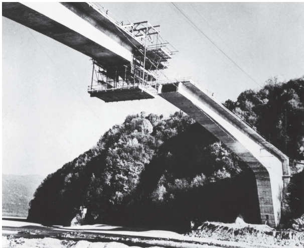
Fig. 10. Ponte sul fiume Tagliamento in località Pinzano, in costruzione (Archivio Storico Politecnico di Milano, fondo Silvano Zorzi, Milano).
