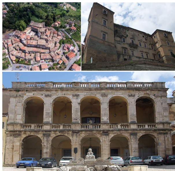
Fig. 2. Palazzo Camuccini a Cantalupo in Sabina, Rieti.
