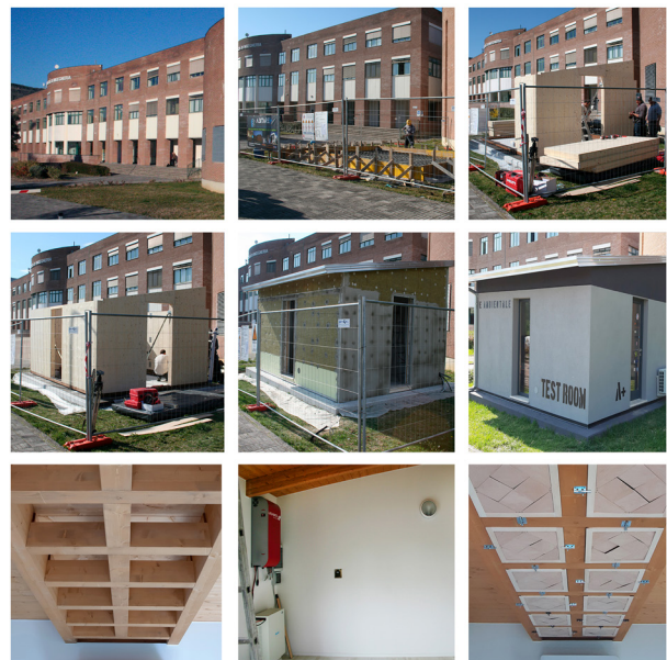
Fig. 8. Realizzazione e installazione della test room per la verifica delle prestazioni simulate (elaborazione grafica degli autori).
