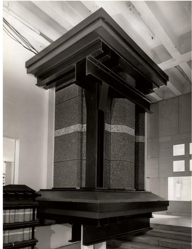
Fig. 8. Esploso delle componenti del sistema costruttivo ed impiantistico nel loro intero sviluppo in alzato, 1961 (rielaborazione grafica degli autori).
