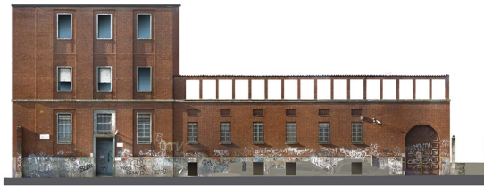
Fig. 10. Centrale telefonica di Città Studi, prospetto su via Villani. Sopra: primo progetto del 1939; sotto: ortofoto elaborata con fotogrammetria digitale (elaborazione grafica degli autori).
