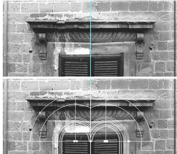
Fig. 7. (sopra) Tracce della bifora della campata 7 al piano nobile.
